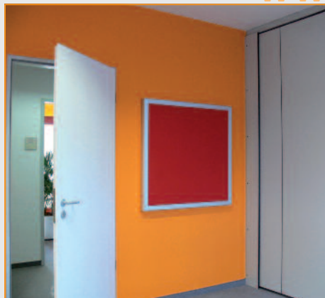
Was hier an der Wand hängt, ist kein Bild, sondern ein Absorber für Geräusche.
