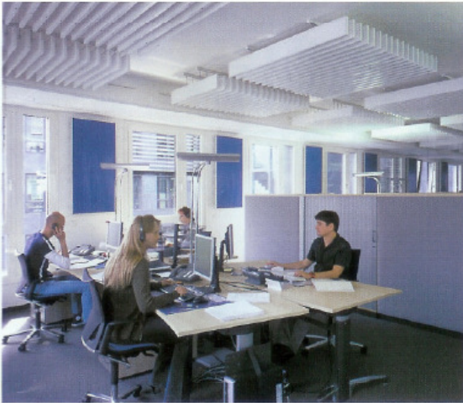
Decken- und Wandabsorber der Firma OWA sorgen in den Büroräumen der Ing.DiBa in Frankfurt für ein „behagliches“ raumakustisches Klima.
